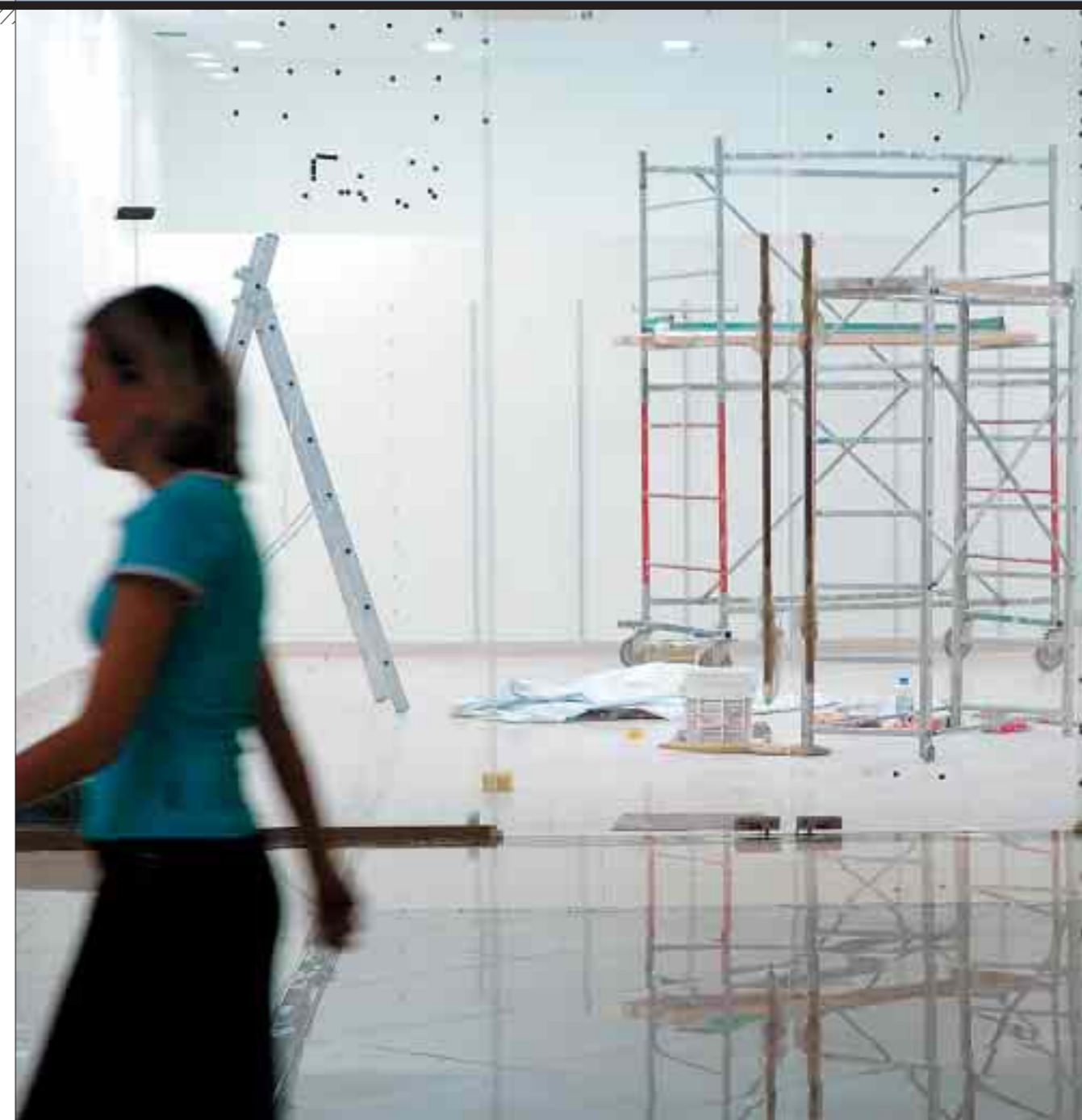
АРЕНДАТОР НАЧИНАЕТ ОТДЕЛКУ ПОМЕЩЕНИЯ, НЕ ДОЖИДАЯСЬ ПОДВЕДЕНИЯ ВСЕХ КОММУНИКАЦИЙ.
